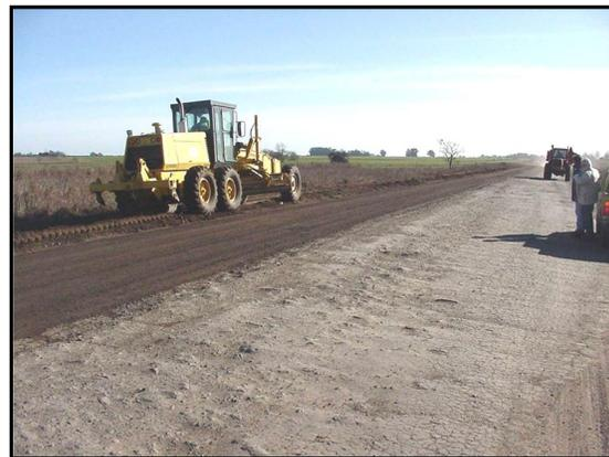
*Rehabilitación:* Llevar un camino deteriorado existente, a sus condiciones originales. Todos los trabajos se realizan en la estructura existente o en el derecho de vía, sin adquisición de tierras.
